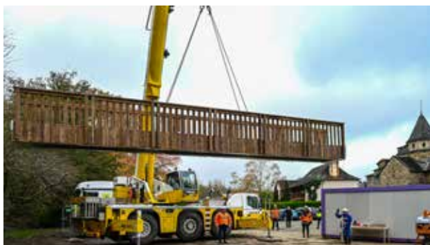
Pose de la nouvelle passerelle sur l'itinéraire du GR78, à l'Hôpital-Saint-Blaise
