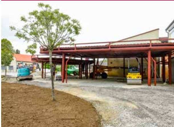
Création d'un préau dans la cour du collège des Lavandières, à Bizanos
