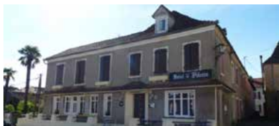
Hôtel Pelerin à Lembeye, un exemple de recyclage d'un foncier existant et vacant en centre-bourg qui verra la création d'une résidence pour saisonniers
