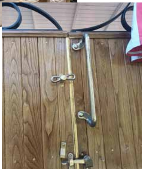
Ferronneries nouves en bronze identiques à l'existant
