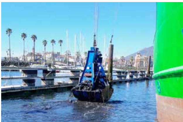
Dragage du plan d'eau de plaisance au port d'Hendaye
